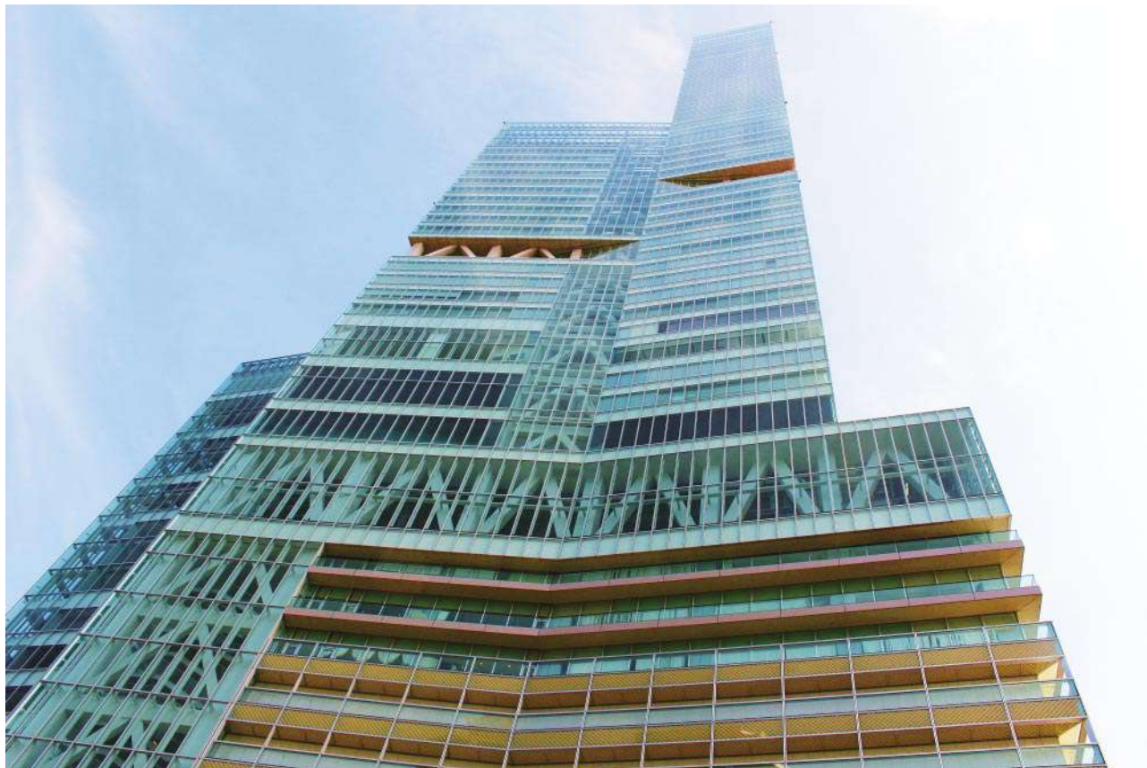
〆ビルとして高さ日本一、あべのハルカス（大阪市阿倍野区）
